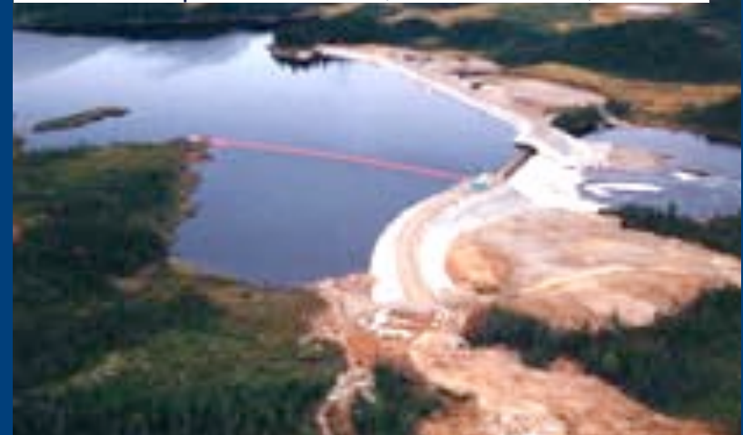
Foto: CHI Energy
