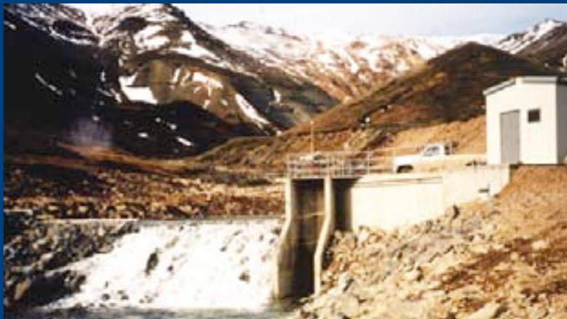
Piccolo impianto idroelettrico di King Cove da 800 kW Paese di 700 abitanti
