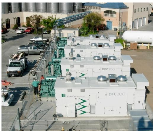
Figura 16. Impianto MCFC alimentato con residui da birrificio.
