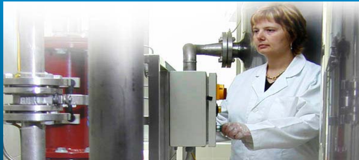
L'unità di microfiltrazione
