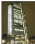
LA TORRE Il grattacielo Intesa in corso Inghilterra
